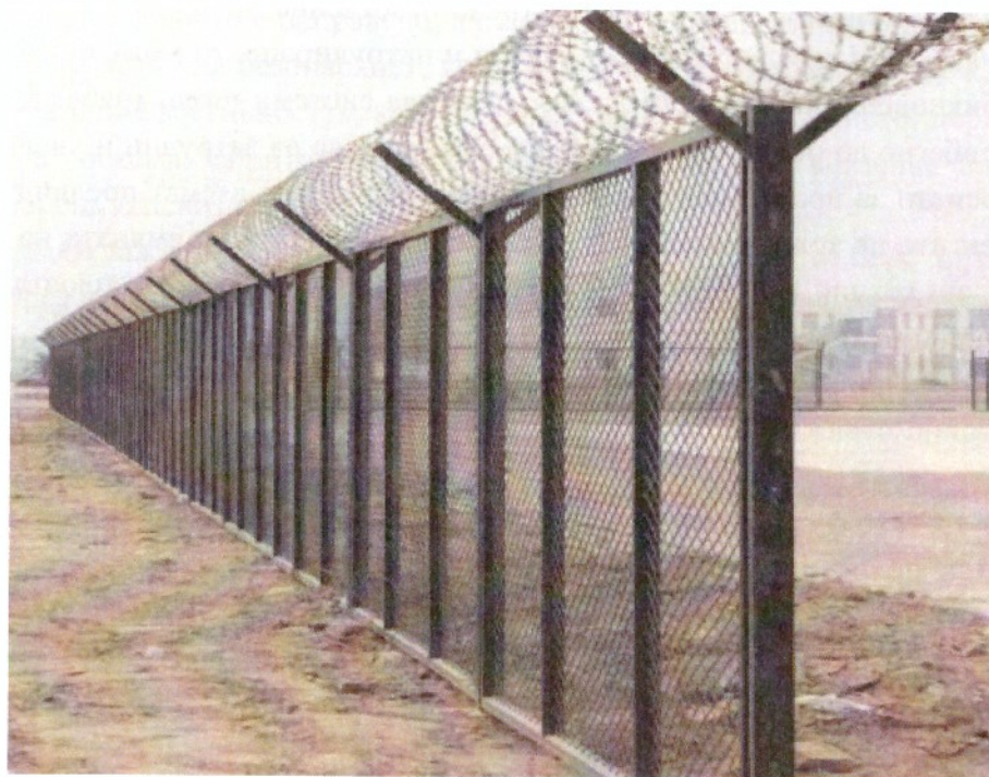
Сн. 3. Ограждения от метална мрежа в комбинация с бодлива тел
